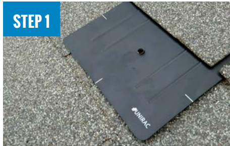
INSTALL FLASHKIT PRO FLASHING
